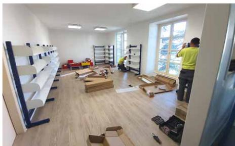
Fin des travaux réalisés en régie pour l'agrandissement de la bibliothèque (suppression de cloisons, ouverture entre salles, réfection des peintures). Réalisation d'un sol plastique « copier-coller » avec la salle existante et montage du mobilier.
