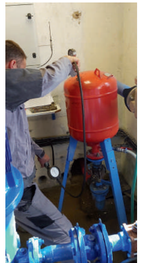
Remplacement d'une électropompe de 60 m 3 /h sur le pompage du Boundoulaou après nettoyage de l'ouvrage et maintenance sur la chaudronnerie.
