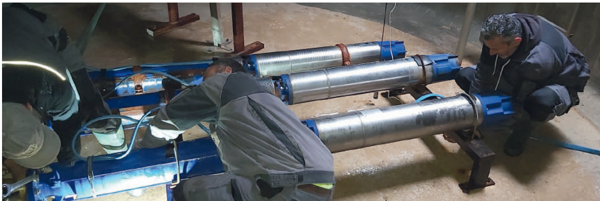
Remplacement d'une électropompe de 60 m 3 /h sur le pompage du Boundoulaou après nettoyage de l'ouvrage et maintenance sur la chaudronnerie.
