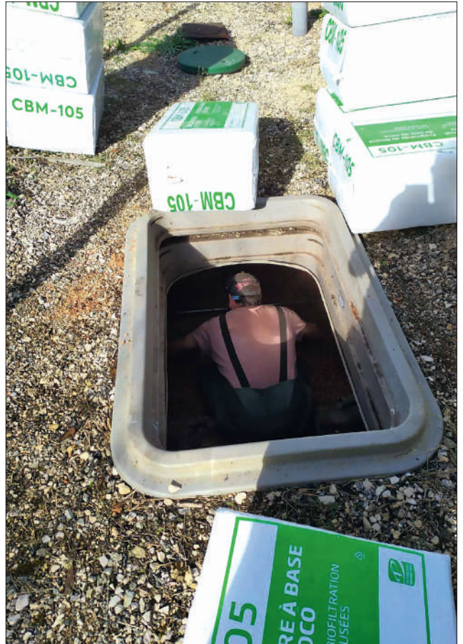
En septembre, réhabilitation complète de la petite station d'épuration de Linas 10 EQ/HA, pour rappel nous avons fait une opération identique sur celle des Tilleuls au printemps 2021. Descriptif de l'opération : Reprise de l'étanchéité, nettoyage et contrôle de la fosse toutes eaux et remplacement du support filtrant.
