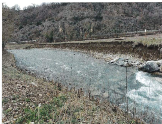
Figure 1 : En amont du seuil n°3
