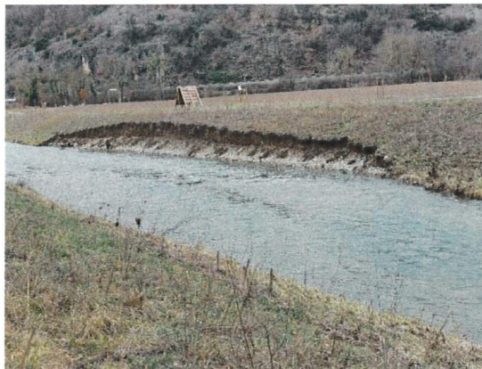
Figure 1 : En amont du seuil n°3
